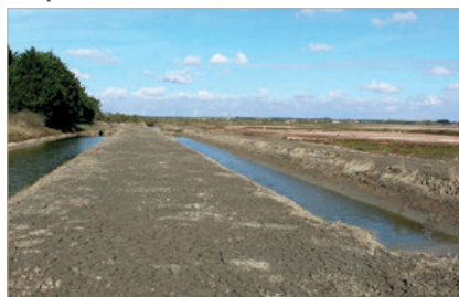
Pendant les travaux
